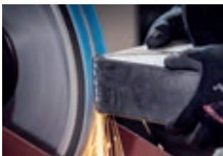
Выравнивание сварных швов
