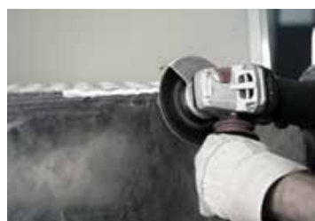
Удаление сварных швов
